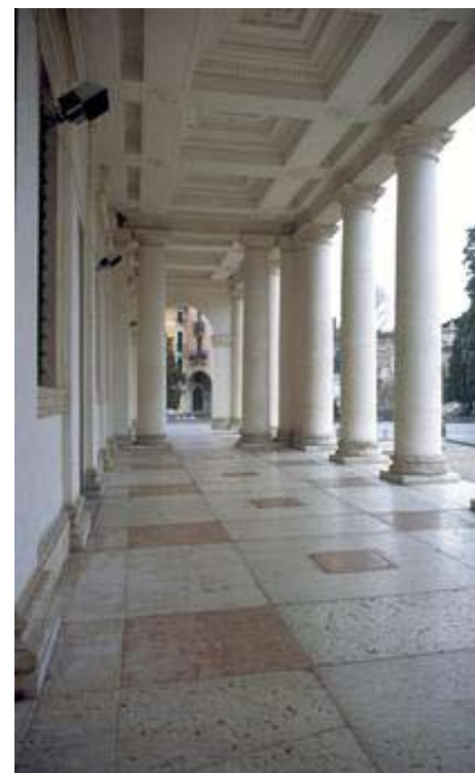
Кессоны на потолке первого этажа
